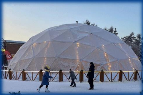
Устройство ледового катка на сквере им. Кирова (г. Иркутск)
